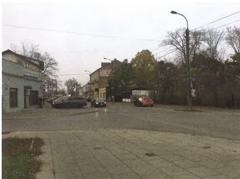
Rys.6 Widok na betonową zabudowę ulicy
